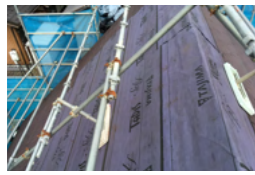
▲防水シート貼り
