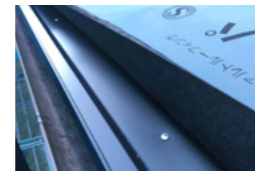
▲水切り板金の取り付け
